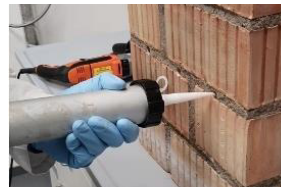
Injekteerimine paigalduspüstoliga
